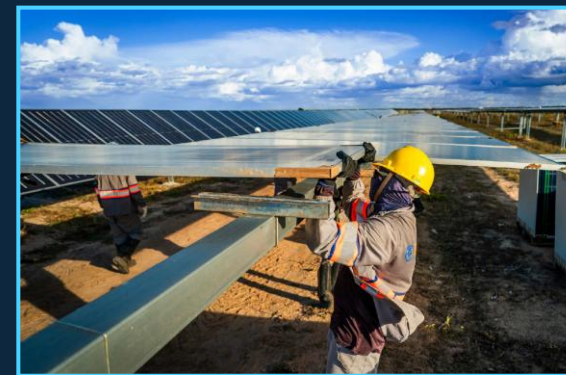
INSTALAÇÃO ELETROMECÂNICA E CIVIL
