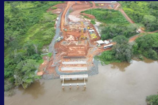
Bacaba: Execução de obras na ponte; ela conectará Bacaba ao Complexo do Moinho de Sossego
