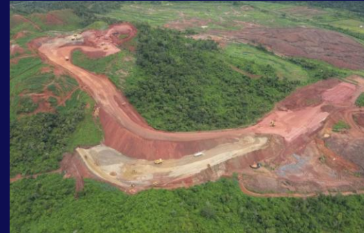
Bacaba: Execução da Pré-remoção (Pre-stripping) e Acessos
