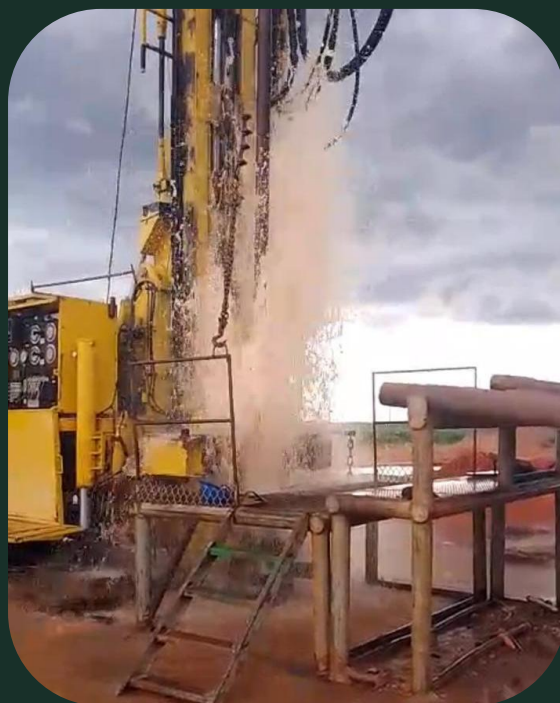
Perfuração poços 300m 3
