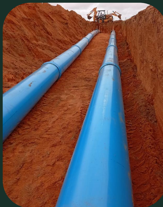
Instalação Adutoras 500mm
