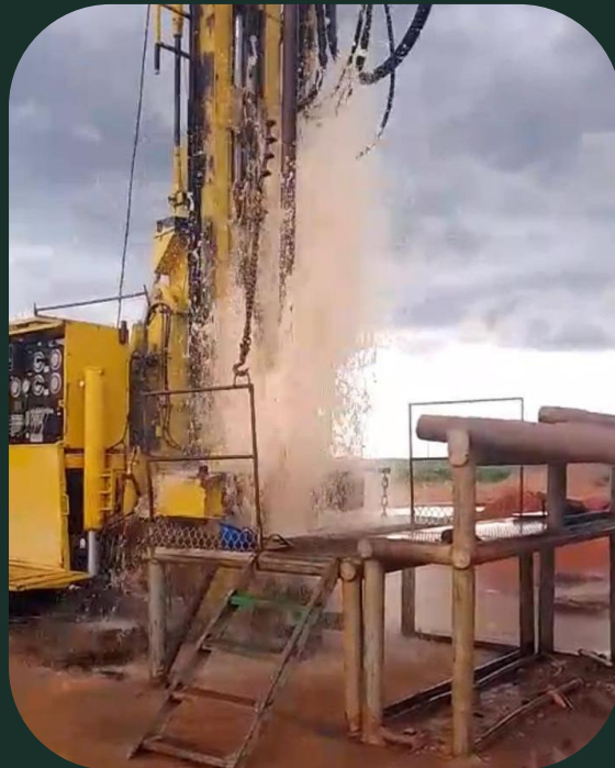
Perfuração poços 300m 3
