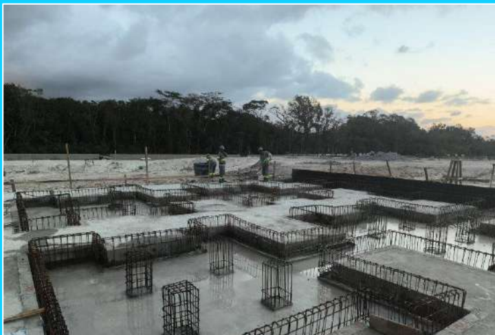
Praia Grande — Implantação da ETA Melvi
