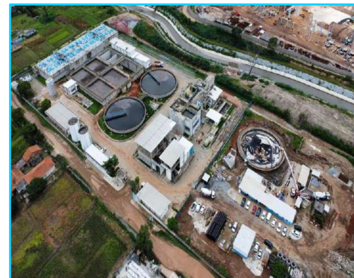
ETE São João
