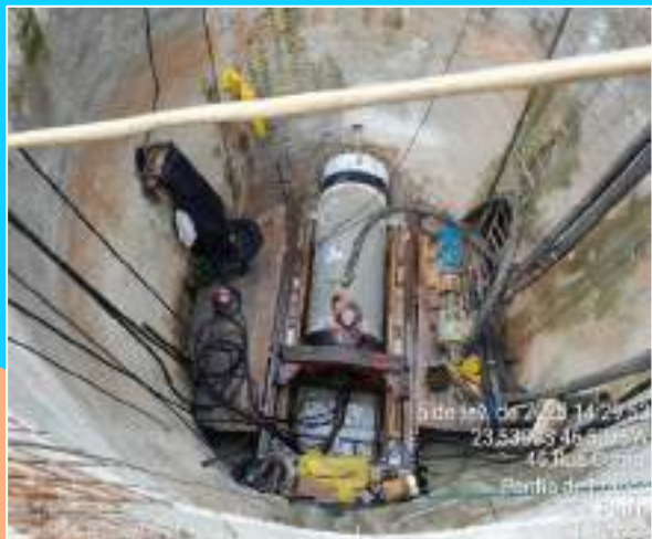
Rincão São Paulo Trunk sewer
