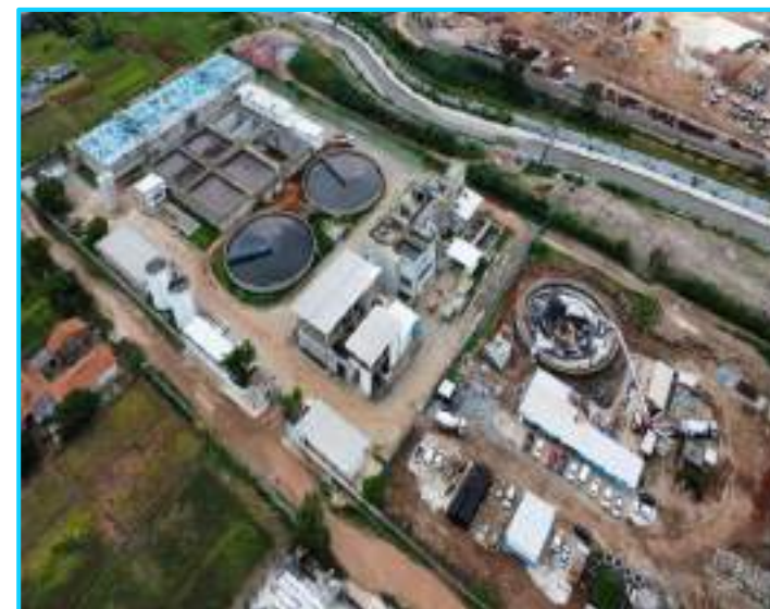
São João WTP
