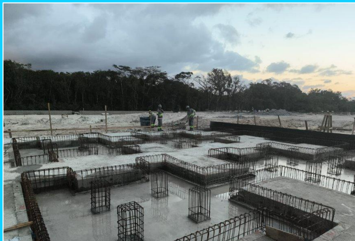
Praia Grande — Implantação da ETA Melvi
