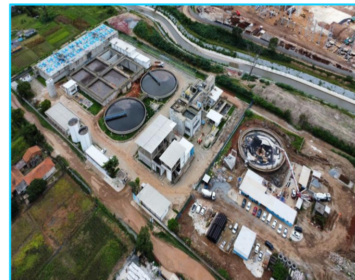
ETE São João
