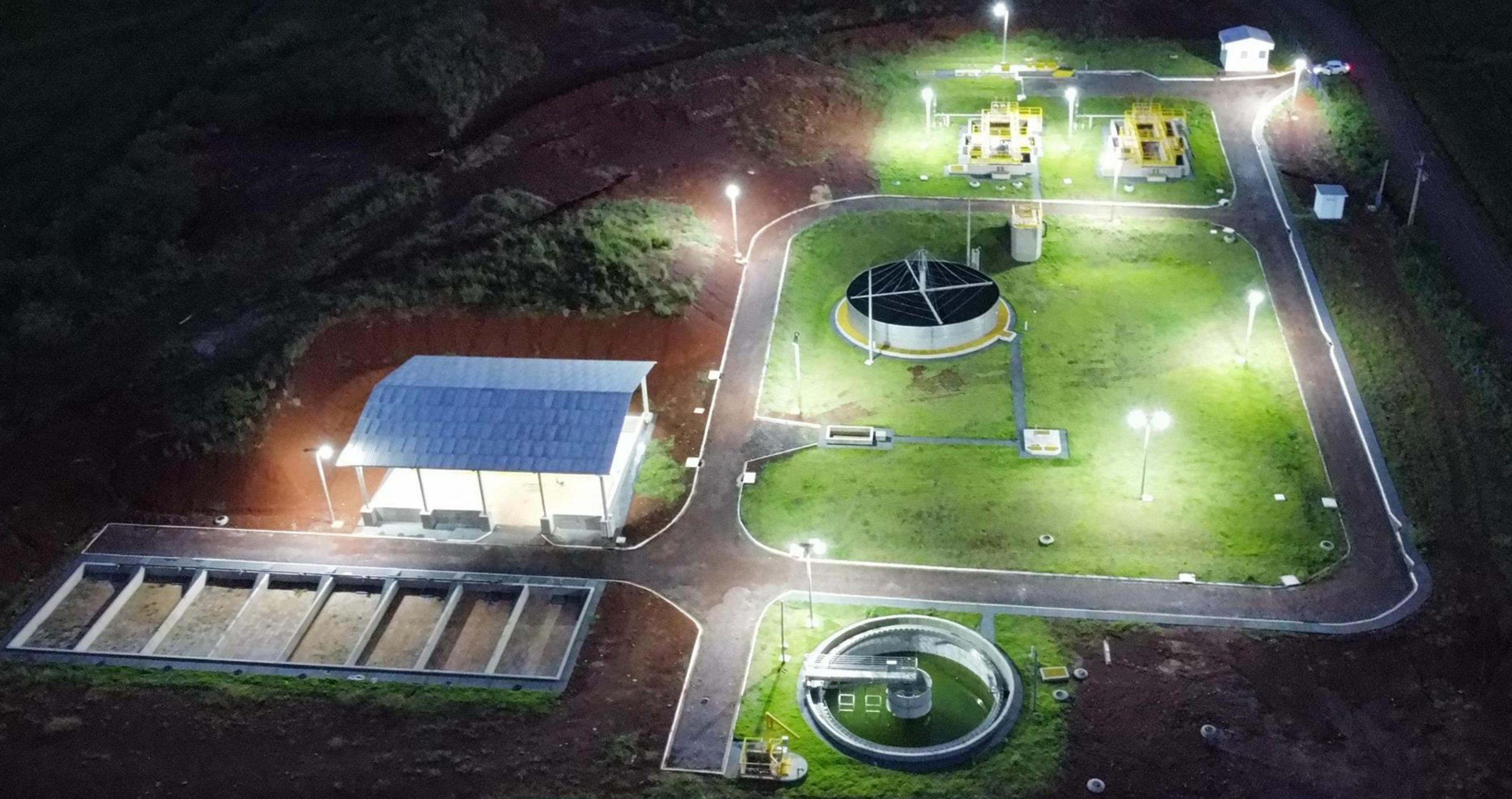
Estação Tratamento de Esgoto - Campina da Lagoa
