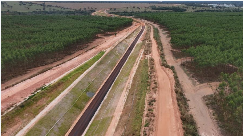
Km 25 – Plataforma concluída
