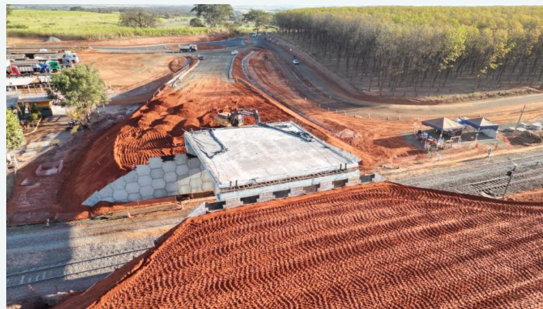
Viaduto Rodoviário | Fernandópolis - km342+460
