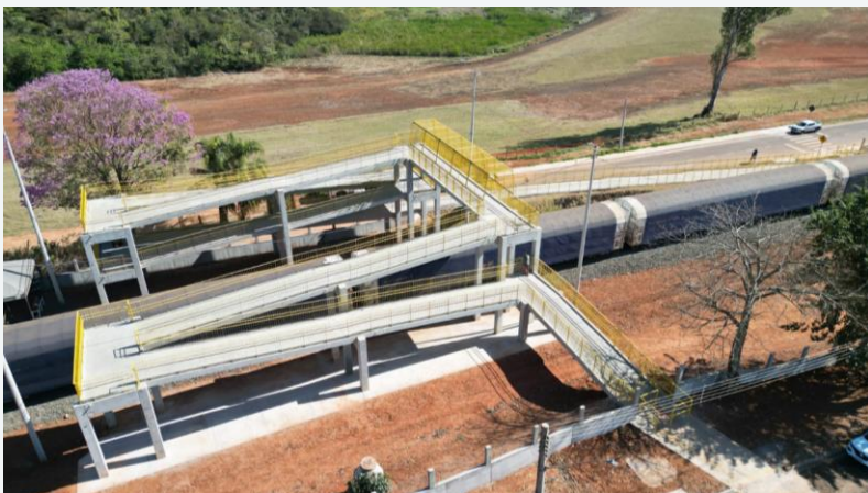
Passarela de Pedestres | Catanduva Km 134+060
