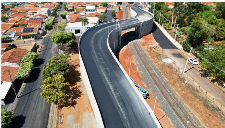
Viaduto Rodoviário | São José do Rio Preto - Km 201+250
