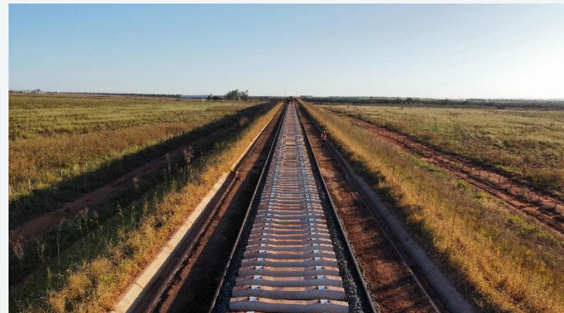
Km 15 – Construção da superestrutura
