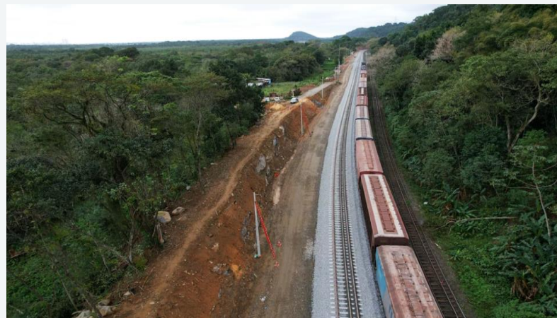
Extensão de Pátio | Solução Paratinga Fase 1 - km111+453
