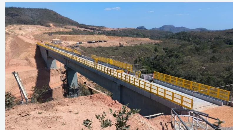
Km 113 - Ponte sobre o Rio São Paulo
