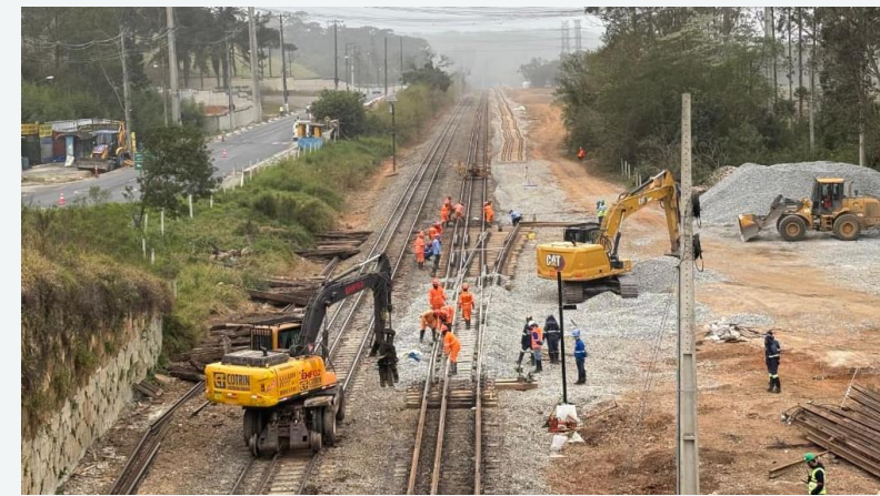
Trecho 1 | Desvio Embu Guaçu SP
