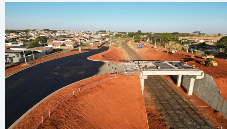
Viaduto Rodoviário | Fernandópolis - km339+930
