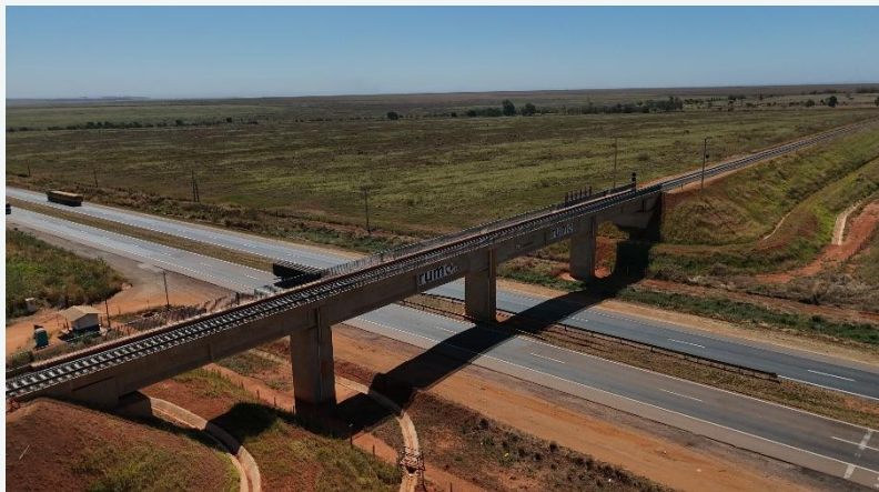
Km 8 - Viaduto sobre a BR163
