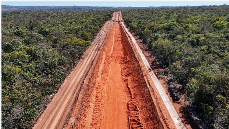
Km 133 – Canaletas construídas e terraplenagem em andamento
