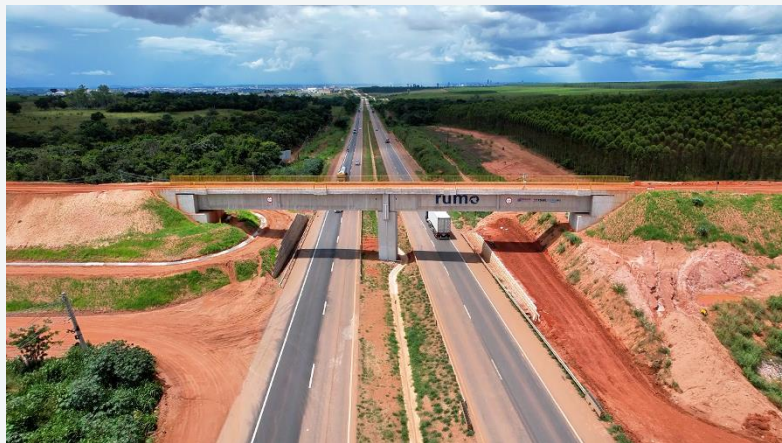
Km 26 - Viaduto sobre a BR163
