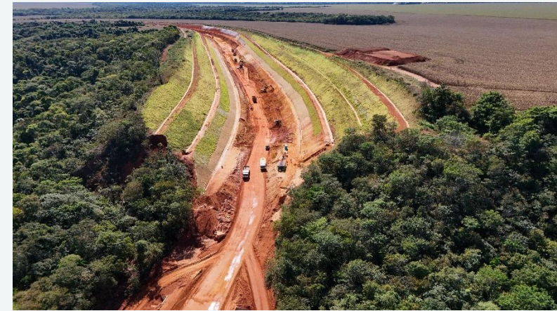
Km 158 – Corte com taludes finalizados com hidrossemeadura
