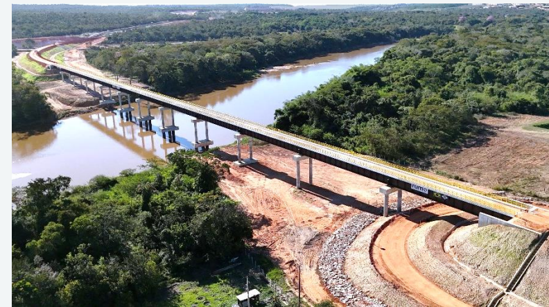
Km 35 - Ponte sobre o Rio Vermelho
