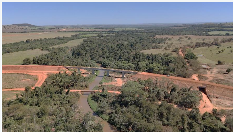
Km 87 - Ponte sobre Rio Areal
