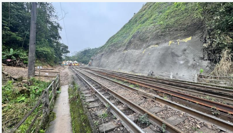
Contenção Serra | Km 79 e 80
