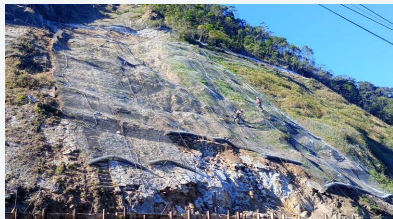
Contenção Serra | Km 79 e 80
