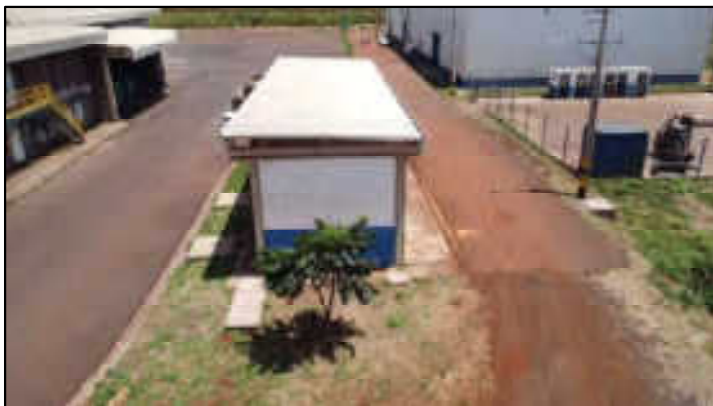
Galpão-oficina e depósito
