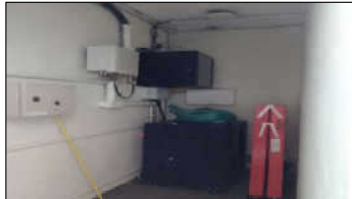
Escritório e armazém de carregamento
