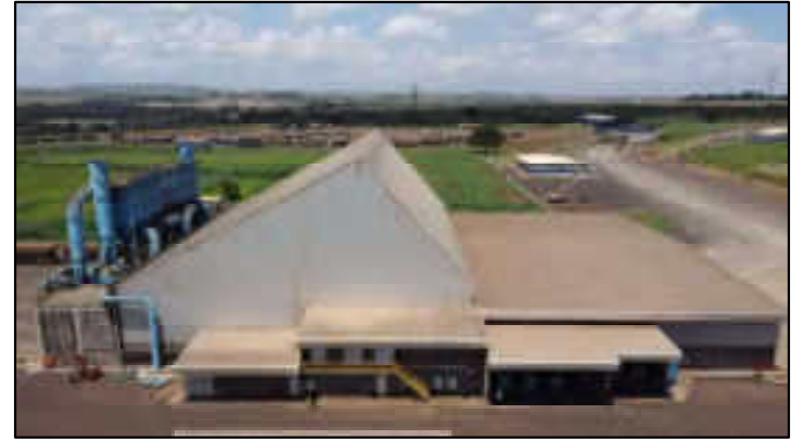
Moega e tombador de recebimento
