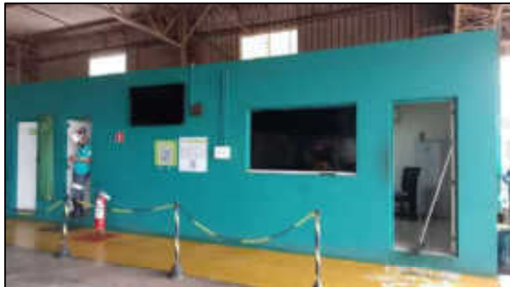
Galpão Pluma – Escritório e banheiros
