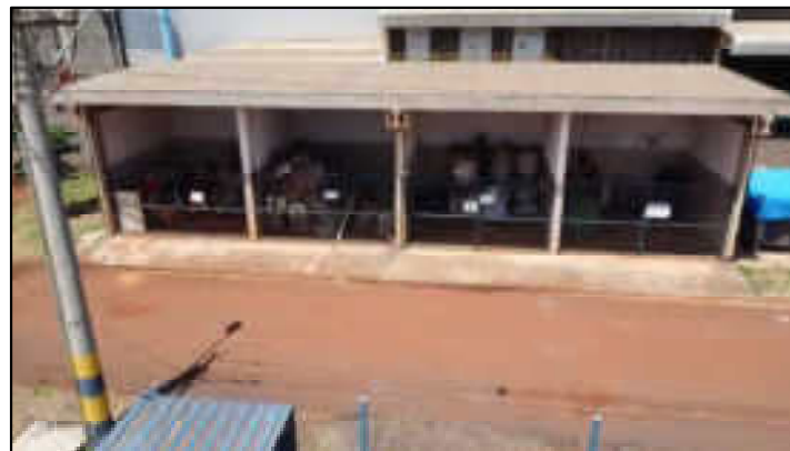
Galpão-oficina e depósito
