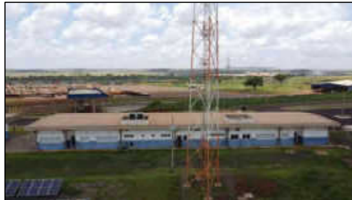
Prédio administrativo e anexos
