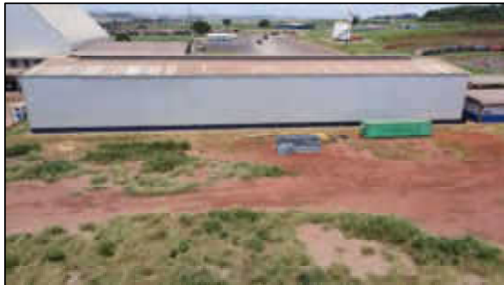
Galpão-oficina e depósito
