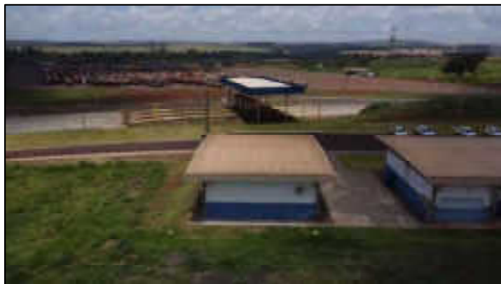
Prédio administrativo e anexos
