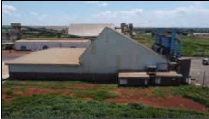
Moega e tombador de recebimento
