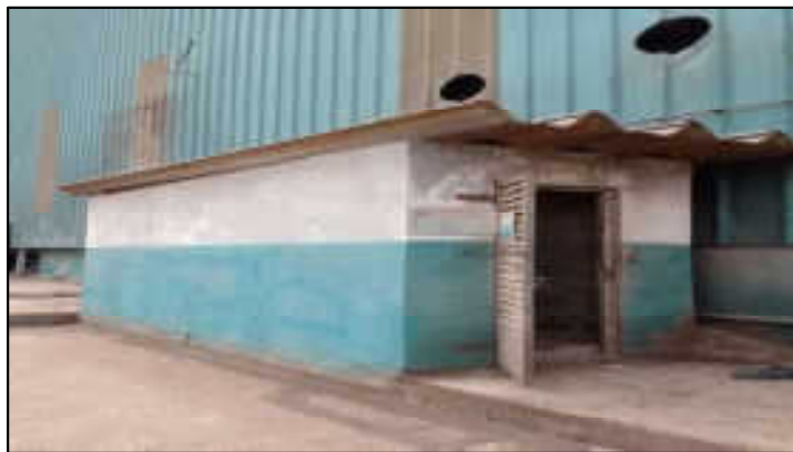
Entrada do fosso do tombador
