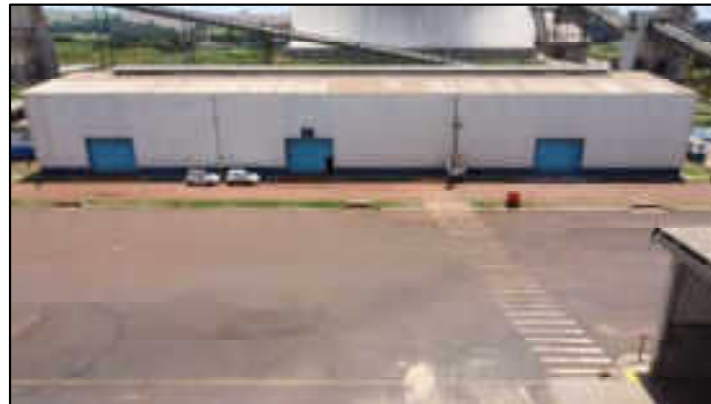
Galpão-oficina e depósito
