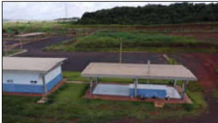
Prédio administrativo e anexos
