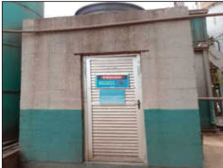
Sala de hidrante
