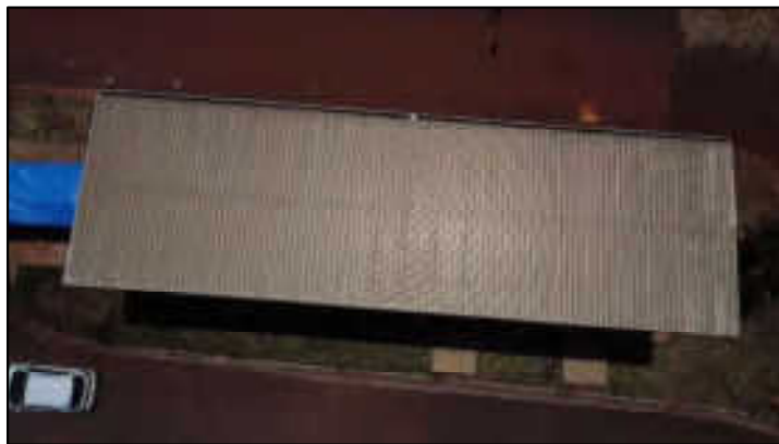
Galpão-oficina e depósito
