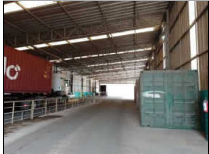
Armazém de carregamento
