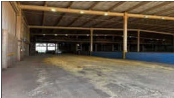
Moega e tombador de recebimento
