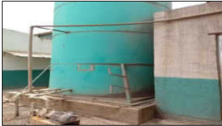
Tanque hidrante
