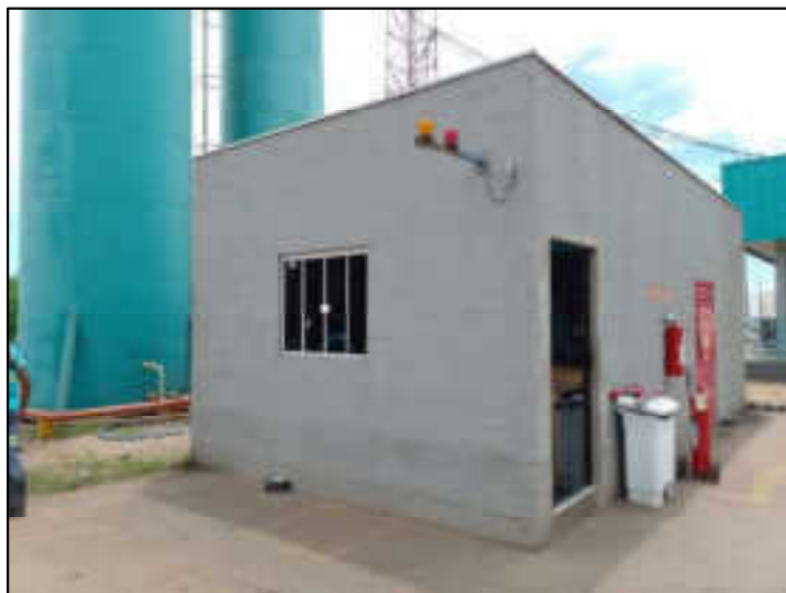
Prédio da segurança do trabalho e casa de bomba de incêndio
