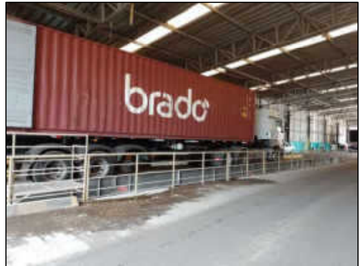
Armazém de carregamento – Balanças rodoviárias
