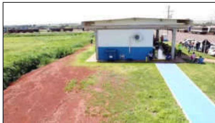
Apoio a motoristas
