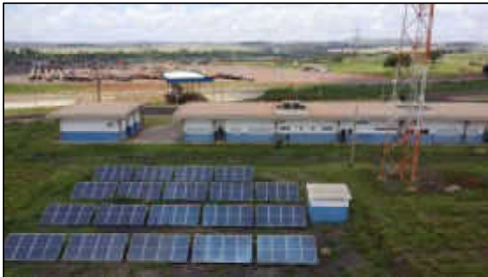
Prédio administrativo e anexos
