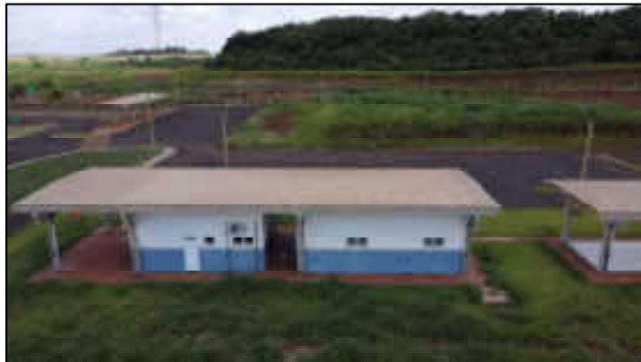
Prédio administrativo e anexos
