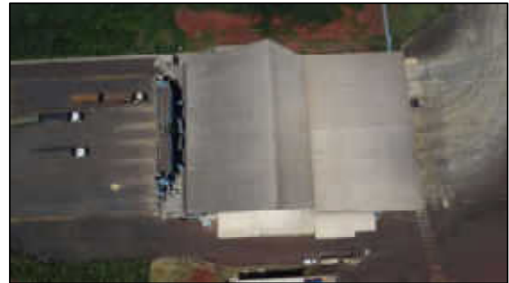
Moega e tombador de recebimento
