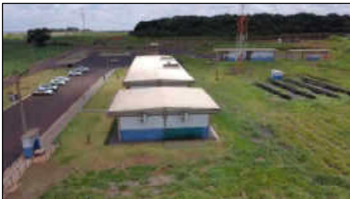
Prédio administrativo e anexos
