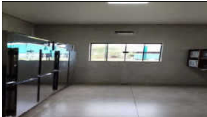
Refeitório – Área da churrasqueira – Nova construção
