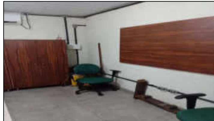
Prédio da segurança do trabalho e casa de bomba de incêndio
