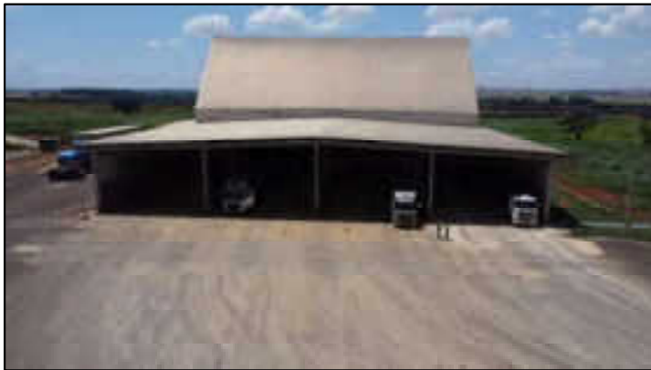
Moega e tombador de recebimento
