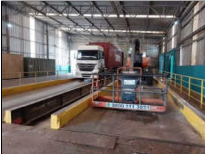
Armazém de carregamento – Balanças rodoviárias
