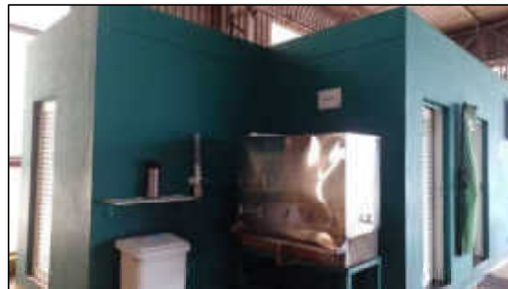
Galpão Pluma – Escritório e banheiros
