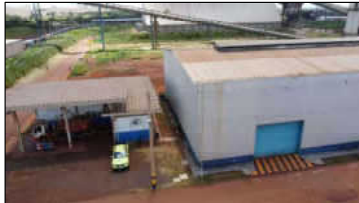
Galpão-oficina e depósito
