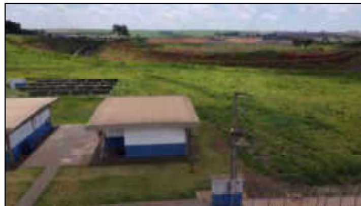
Prédio administrativo e anexos
