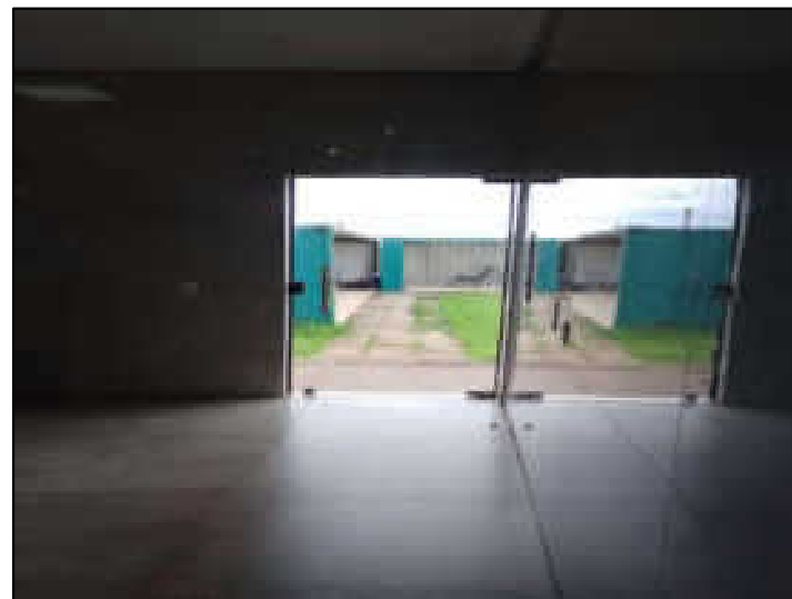
Refeitório – Área da churrasqueira – Nova construção
