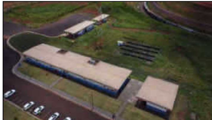
Prédio administrativo e anexos
