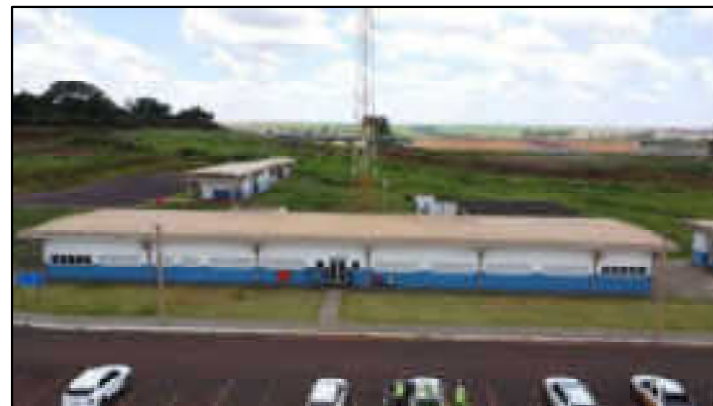
Prédio administrativo e anexos
