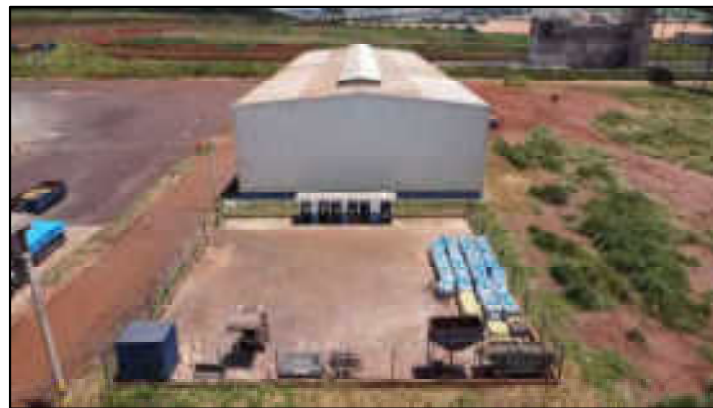
Galpão-oficina e depósito
