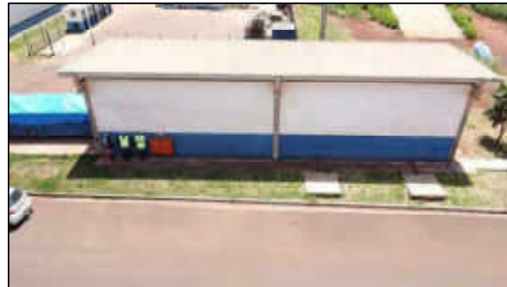
Galpão-oficina e depósito
