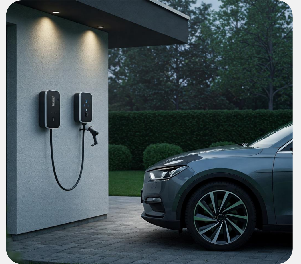
Instalação de carregador para carros elétricos
