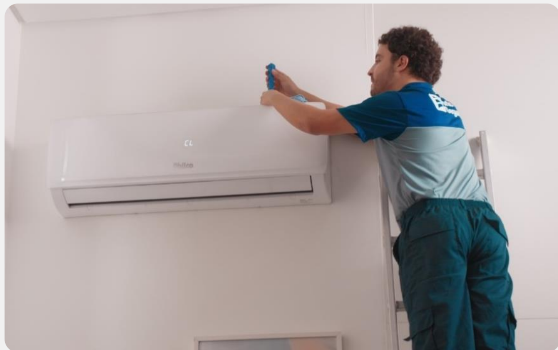
Instalação de ar-condicionado
