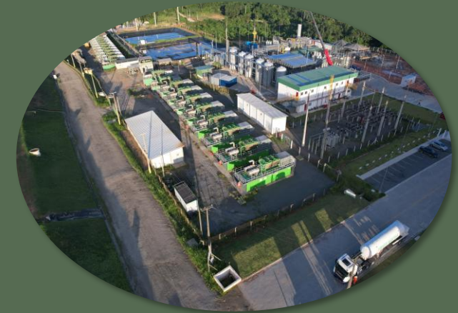
Biometano – Jaboatão dos Guararapes Início de operação previsto: 2S25
