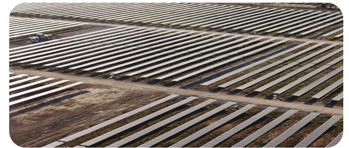
Usina fotovoltaica em Minas Gerais
