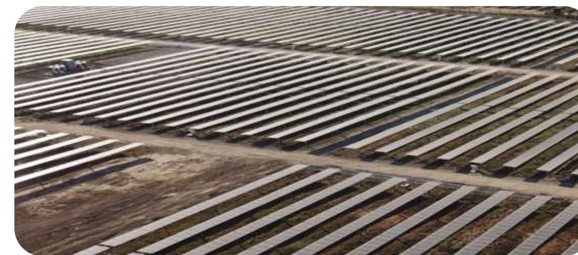
Usina fotovoltaica em Minas Gerais
