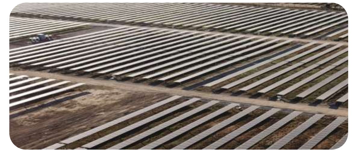
Usina fotovoltaica em Minas Gerais
