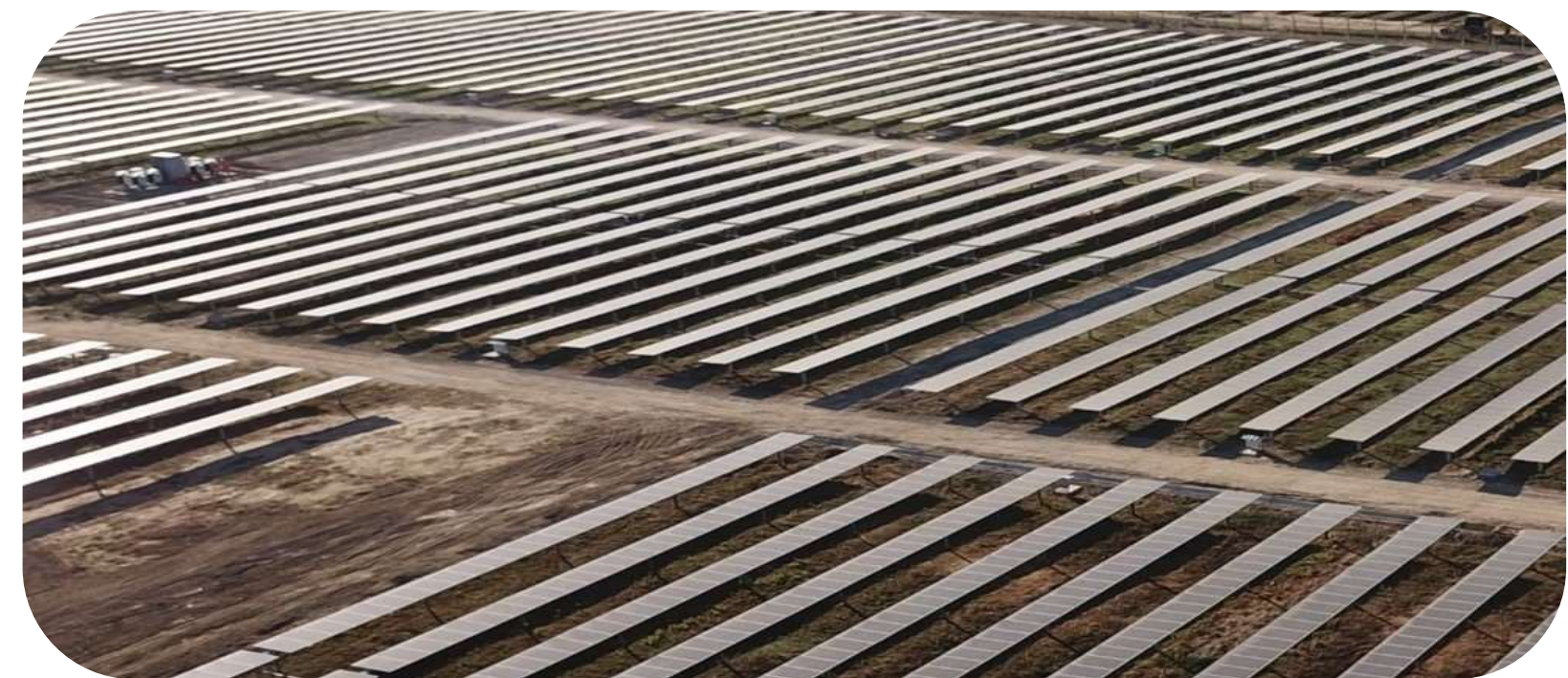
Usina fotovoltaica em Minas Gerais
