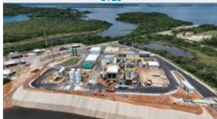
Captação: Vista Aérea geral
