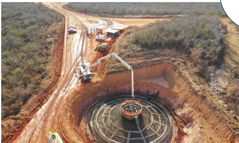
Concretagem das fundações
