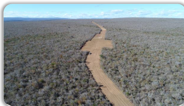
Terraplanagem do Conjunto Eólico Campo Largo II
